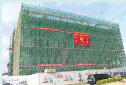
2017.05.04 先进院二期建设工程二标段主体结构封顶
